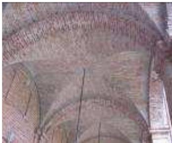
**Volte a crociera durante una prova di carico impulsivo**
